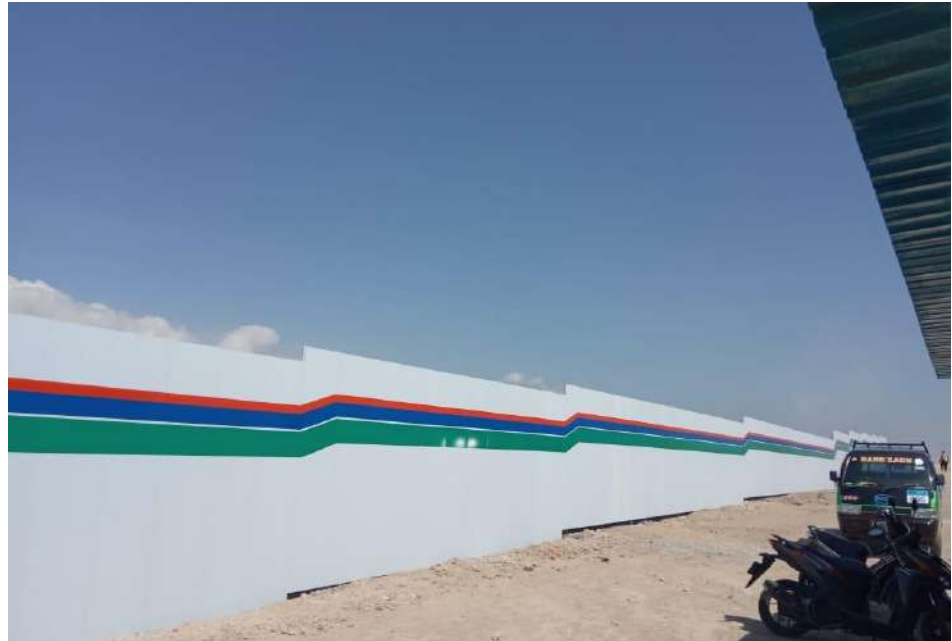
Gambar Pagar yang sudah dilapis dengan MMT atau sejenisnya.
