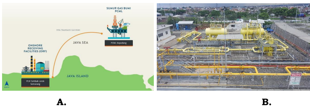
Gambar 5.2. Sistem distribusi gas bumi di Jawa Tengah (A. Skematik gas bumi dari Kepodang ke Tambak Lorok yang dibangun PT. kalija. B. Stasiun penerimaan dan pengukur gas milik PT. Kalija (Kuning tua-bawah), dan milik PT. SPP (kuning muda-atas)).
